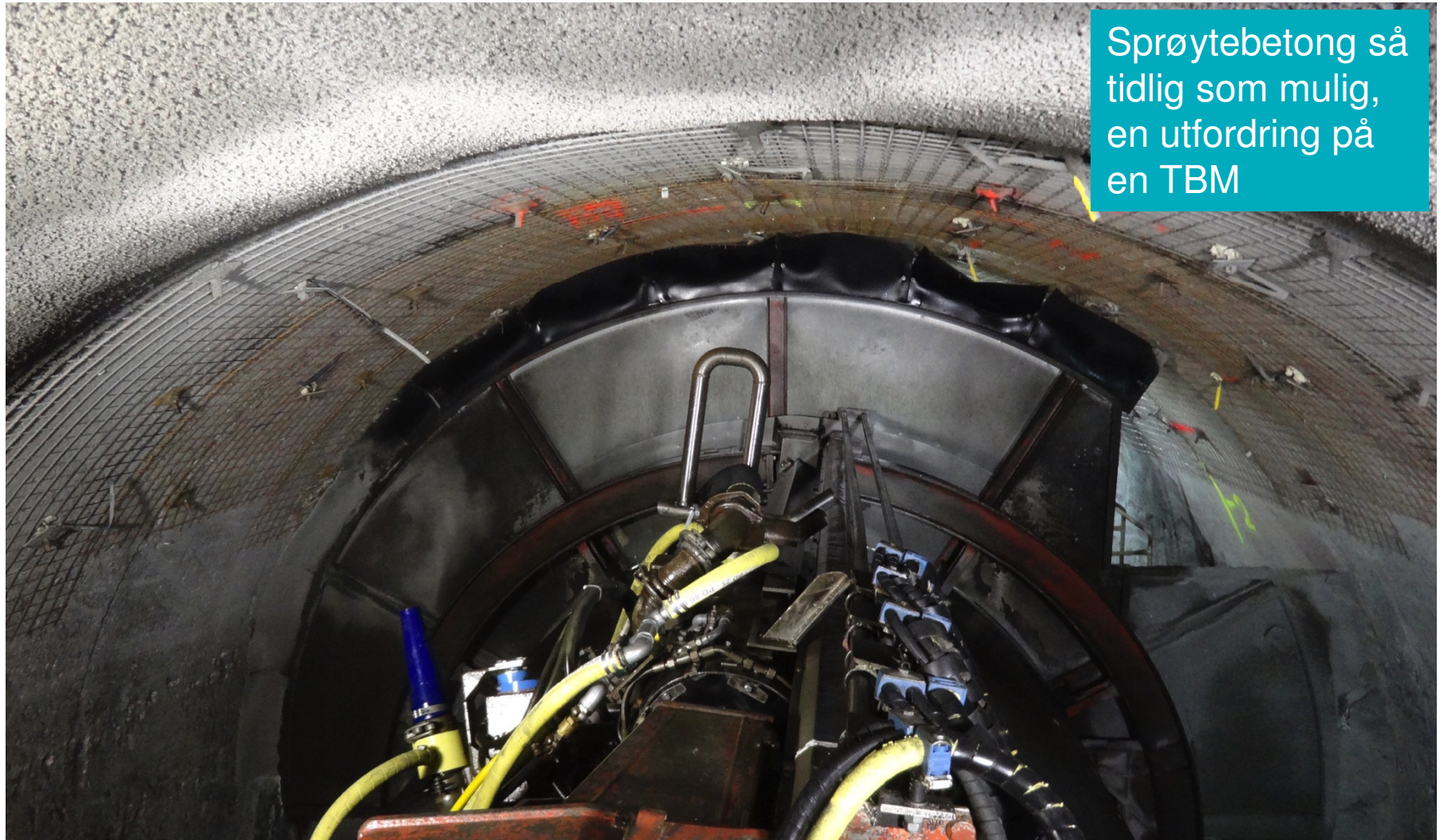
Foto: Sprøyterobot på TBM fra prosjekt i Sveits
