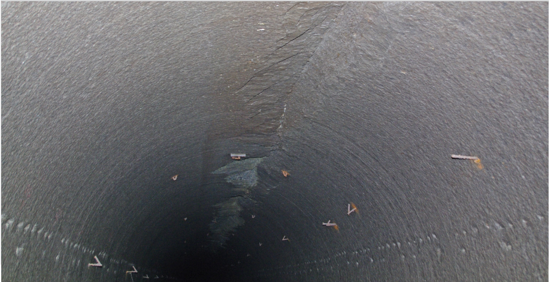
Foto (Sweco): Ø3.5m TBM tunnel Reinoksvatn-Fossvatn, Kobbelv kraftverk
