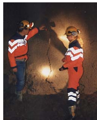
Frøyatunnelen, 10 cm sprøytebetong (sfr)
