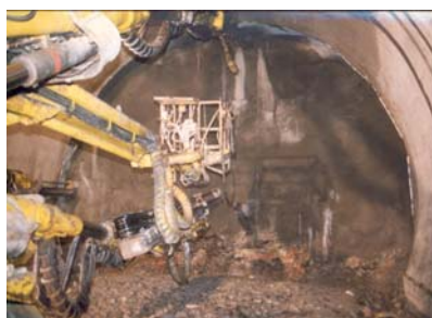
Frøyatunnelen, 10 cm sprøytebetong (sfr)
