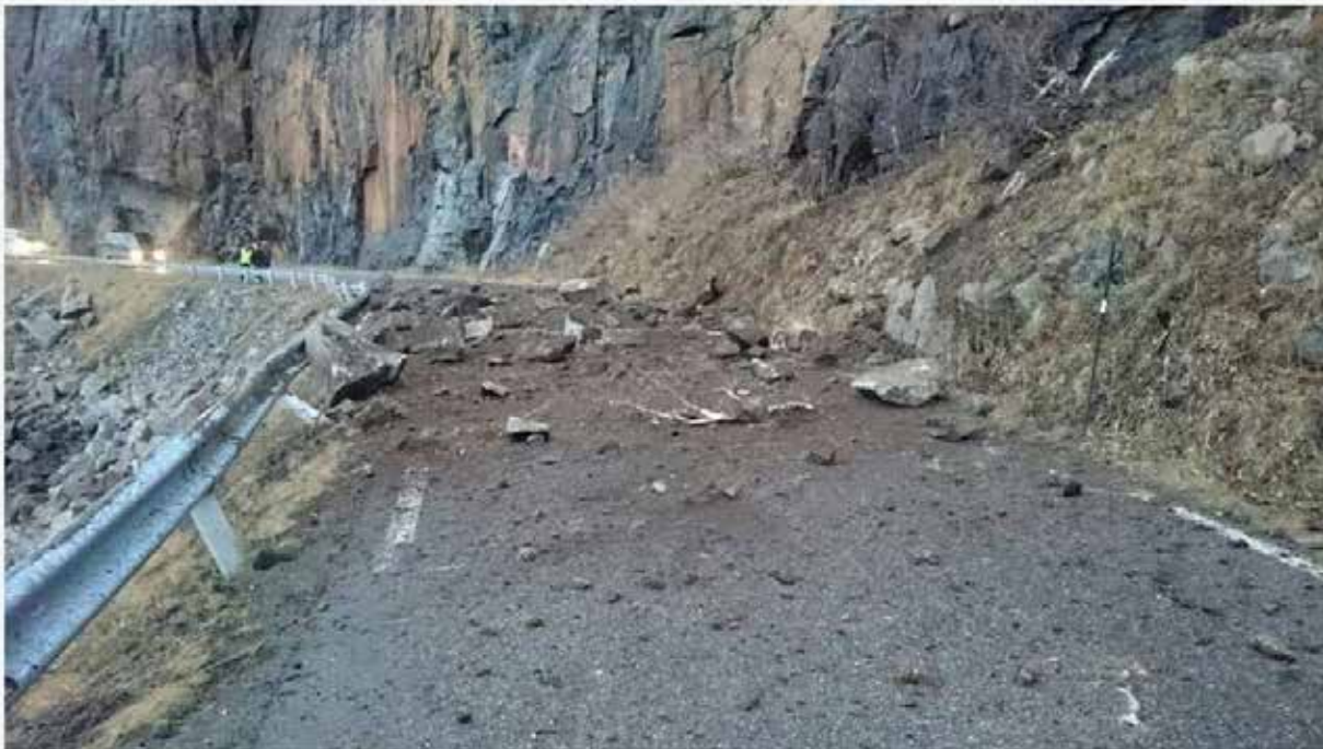
Bildet viser steinraset som har gått ved Måvika sør for Roan sentrum. FOTO: ROGER GJESSING
