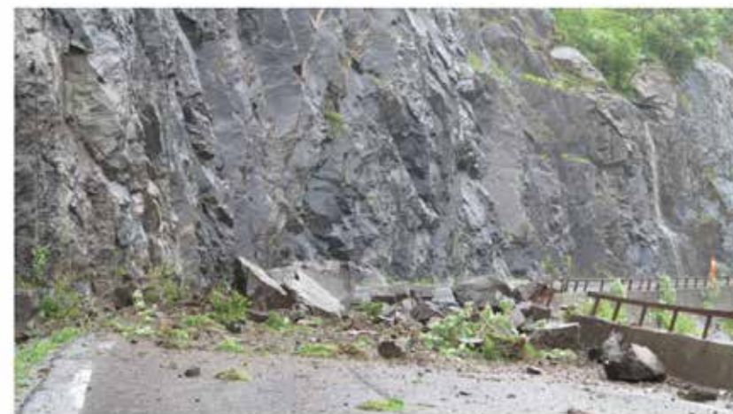
Et steinras på ca 20 meter sperrer fylkesvei 14 i Roan. FOTO: JOAR HAUKNES / ROAN KOMMUNE
