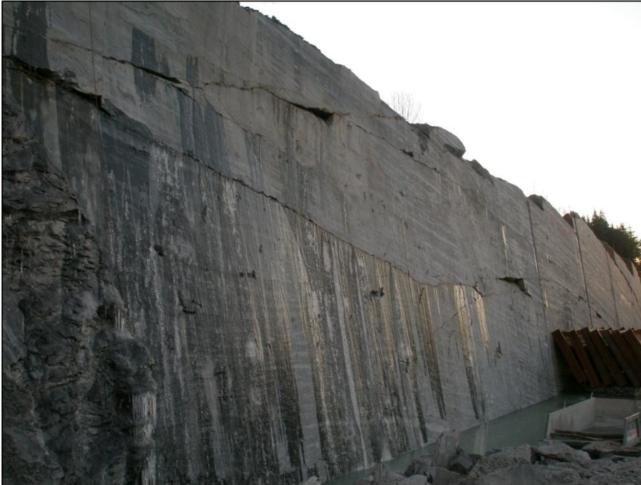
Dobbeltspor Lysaker – Sandvika, wiresaget skjæring i leirskifer
