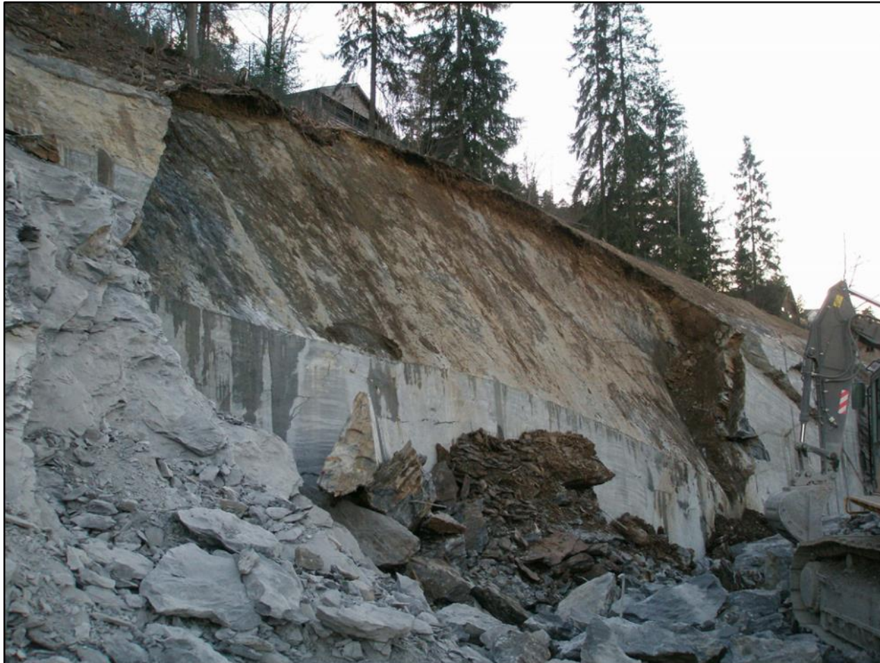
Dobbeltspor Lysaker – Sandvika, wiresaget skjæring i leirskifer
